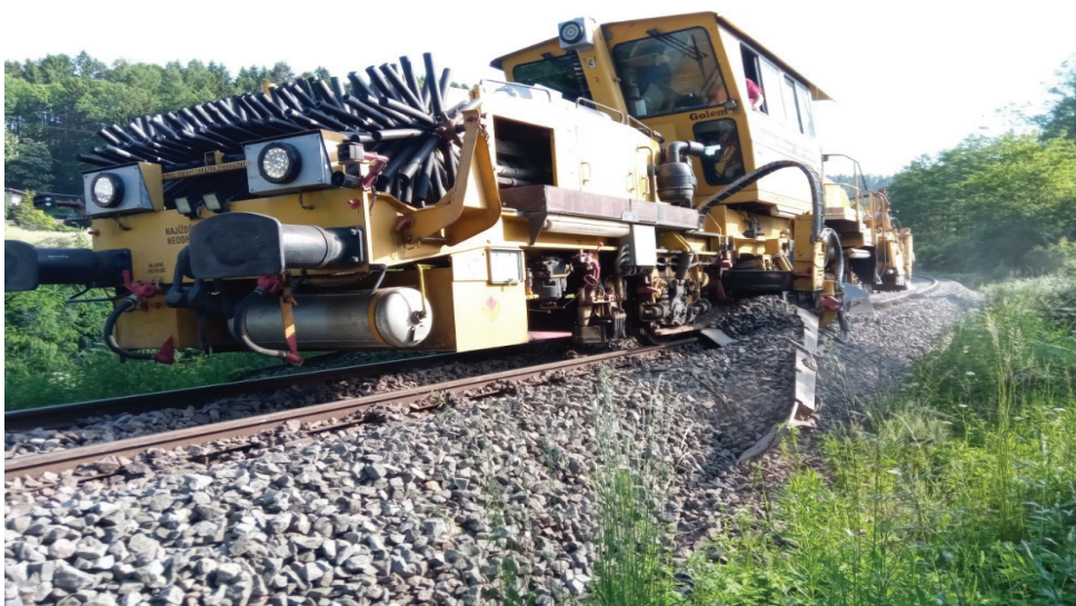
Technologie úpravy kolejového lože do profilu
