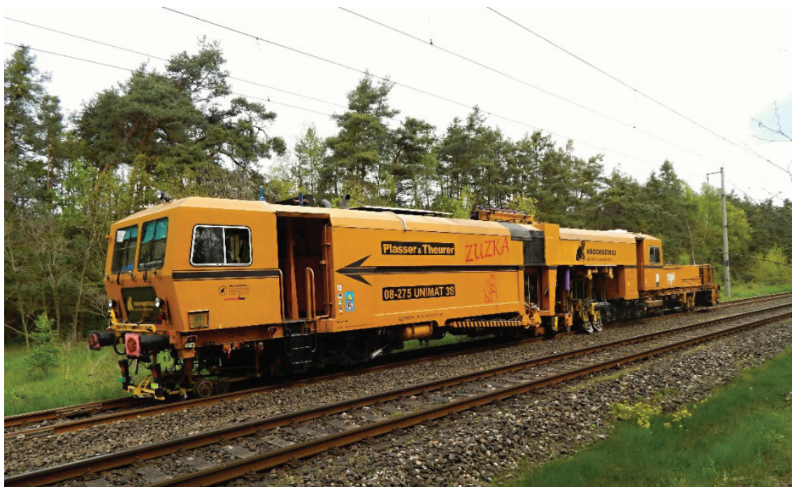
Technologie pro úpravu směrového a výškového uspořádání kolejí a výhybek – automatická strojní podbíječka
